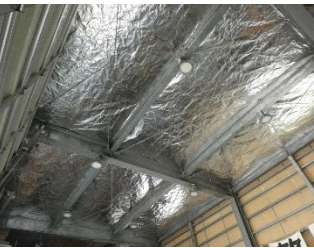
2025年10月(施工直後)
