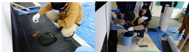
ハynes防水・タフネスファイ ン防水の施工体験
