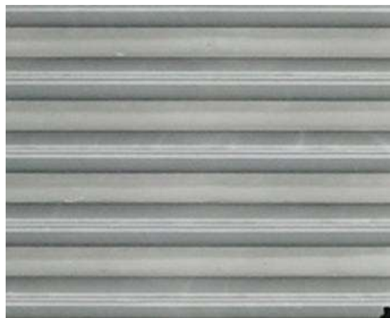
図1.久喜工場屋根から高さ14mの拡大写真
