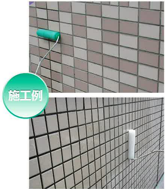
クリアウオール CP-100 [下塗用] 塗布状況
