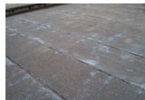
露出アスファルト防水 (トップコートの消失)
