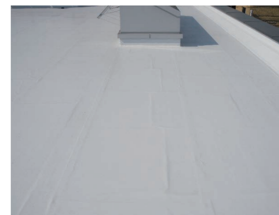
断熱材の段差
