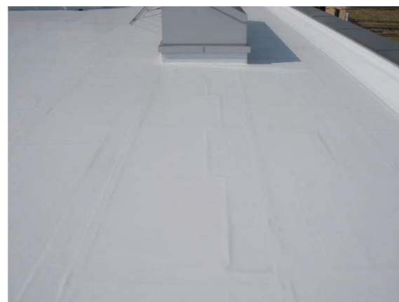
断熱材の段差
