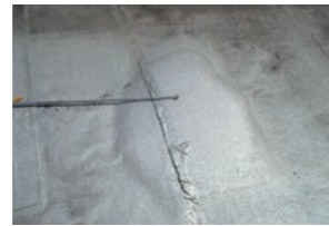
露出アスファルト防水 (平場防水層の著しい膨れ)
