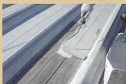
アトムレイズと下地との接着を最良の状態にするための下地調整システムです。アトミクスの幅広い製品対応で培われた接着技術が使われています。
