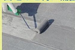
補強布を芯材として含浸したアトムレイズSP（増粘タイプ）が一定の厚みにシート化され、強靭な補強層を構築します。シートのジョイント部、段差などで塗膜の膜厚の確保が難しい場所に対応します。D工法では全面に採用されています。
