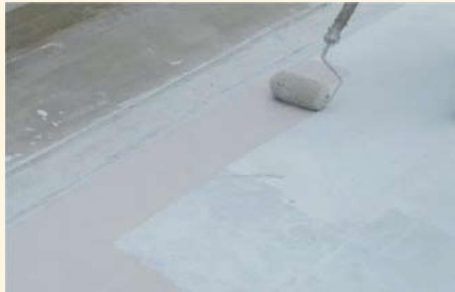
ローラーでの施工(2~3回塗り)
