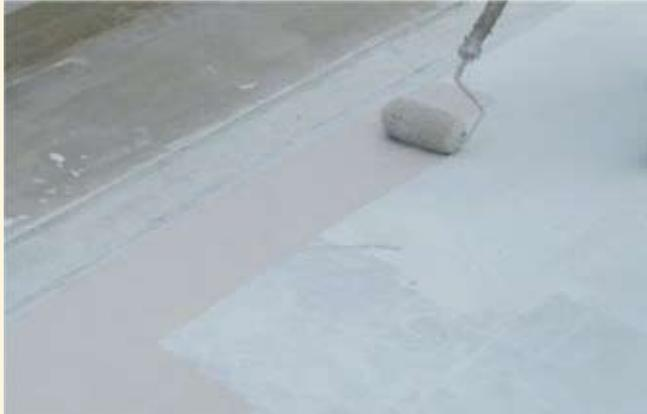
ローラーでの施工(2~3回塗り)
