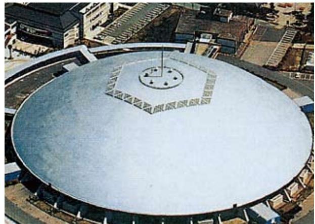
既存防水層を撤去せずに改修する「かぶせ工法」に適しています。
