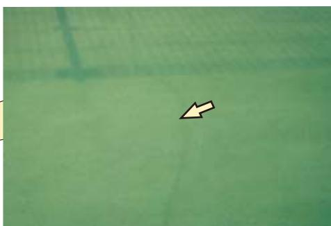
下地コンクリートにひび割れが発生しているが
