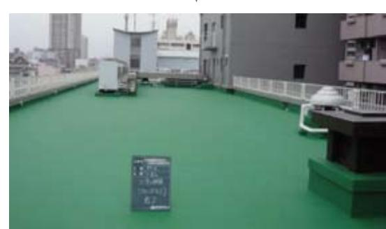
脱気筒は100～150m<sup>2</sup>に1箇所を目安に設置します。
