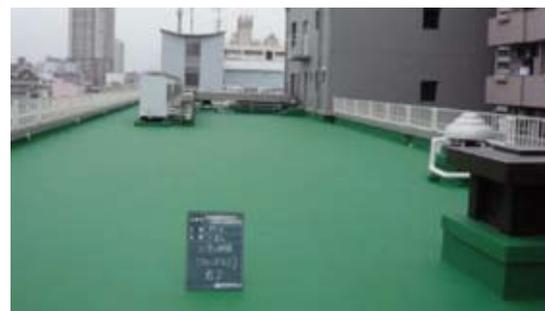
脱気筒は100~150m<sup>2</sup>に1箇所を目安に設置します。
