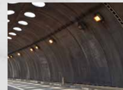
トンネル・アンダーパス
