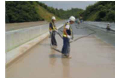
●吹き付け施工
