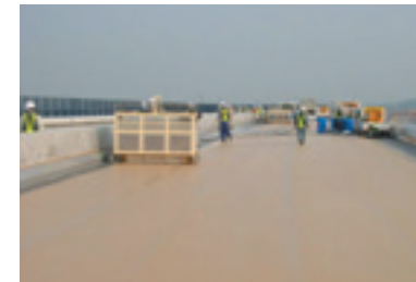
●ロボット施工
