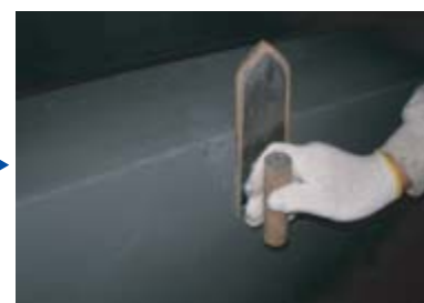
プライマー兼 素地調整材塗布
