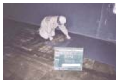
素地調整材塗布 (レジテクト EP-F)
