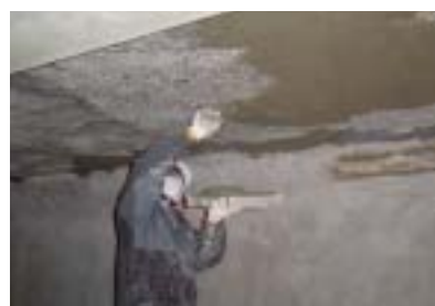
断面修復 (ダイラックススーパー #100又は、#60)
