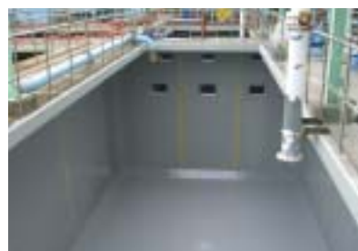
● コンクリートライニング
