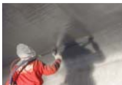
ポリウレア樹脂吹付 (レジテクト 5000)
