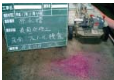
フェノール検査 (劣化部除去確認)
