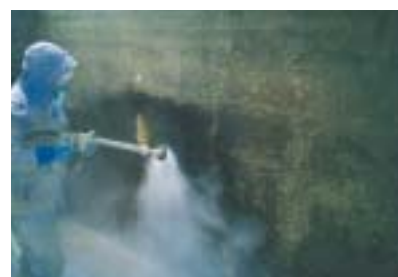
劣化分除去 (超高压洗浄)
