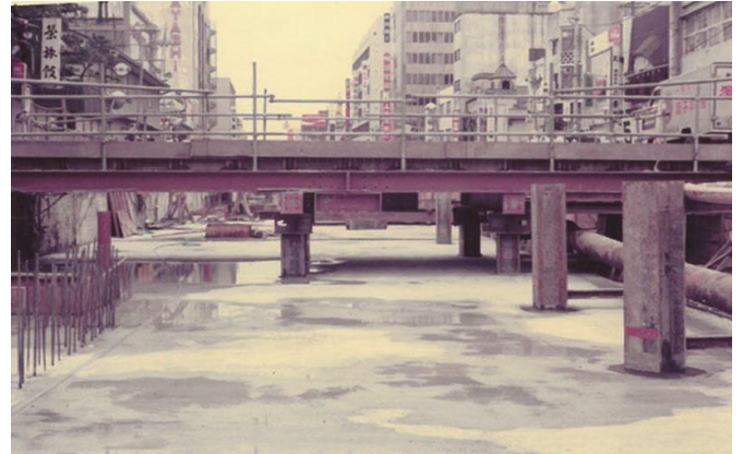
▲1975年 西堀地下駐車場工事風景です
