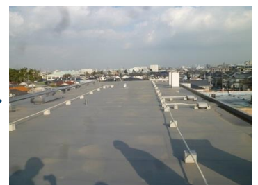
▼施工完了 塩ビ系シート防水外断熱工法
