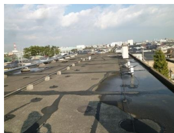
▼施工前 アスファルト露出防水
